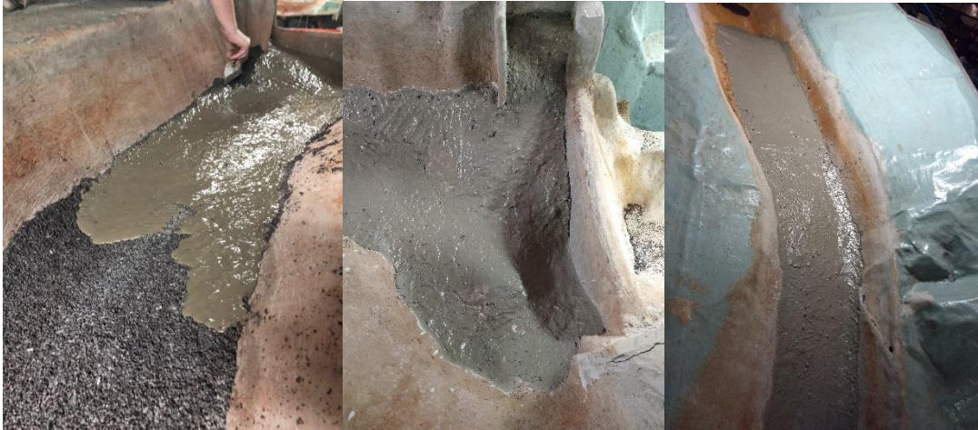
Figura 16 – Camada de argamassa sobre a borracha
