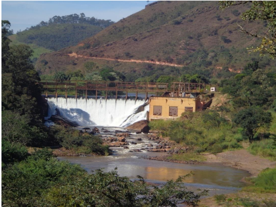
Figura 1 – Vista de jusante da PCH Salto do Paraopeba
