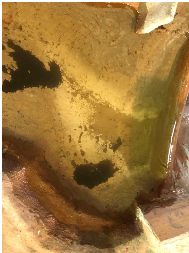
Figura 28 – Figura durante a execução da segunda parte
